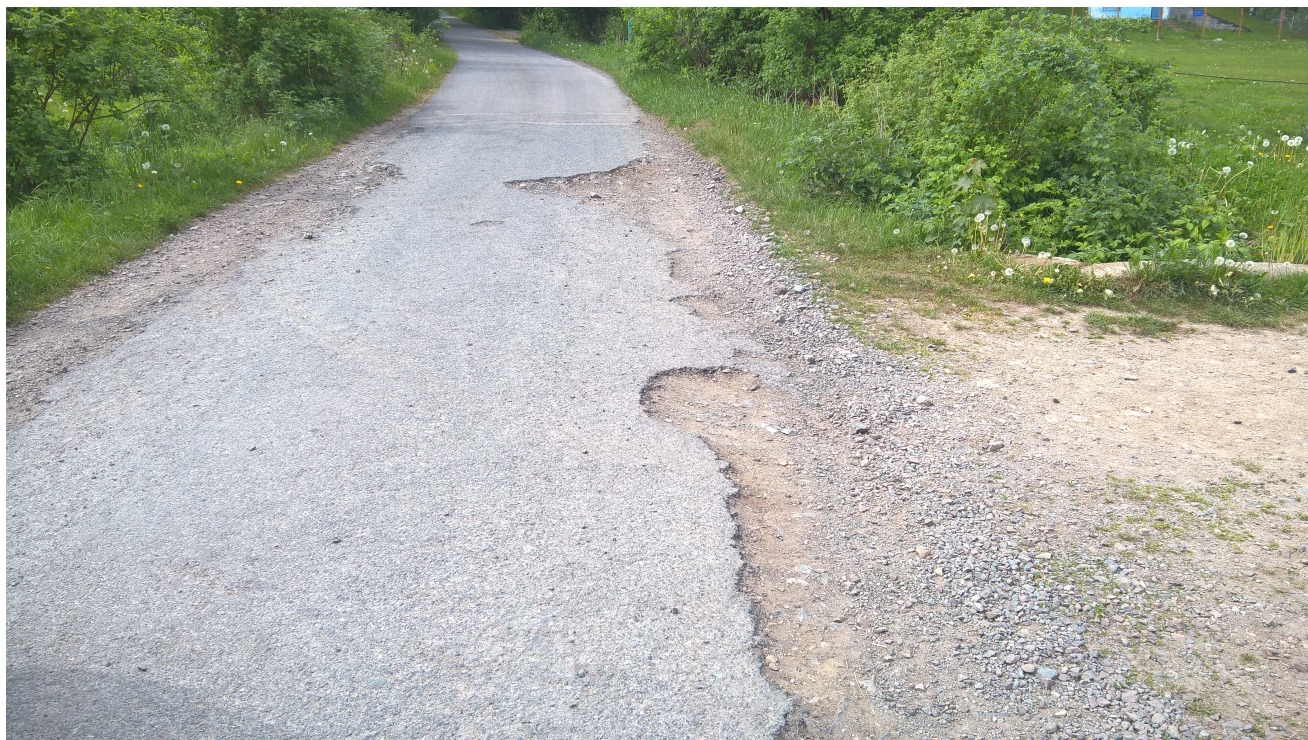
Fot.3. Uszkodzenia nawierzchni
