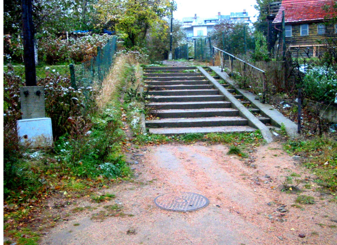
Fotografia 6 schody pomiędzy ciągiem pieszo jezdnym i pieszym
