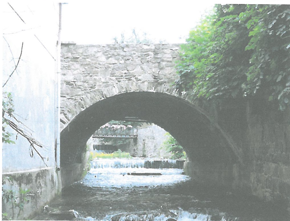
Fot. 3. Widok elewacji obiektu od strony dolnej wody
