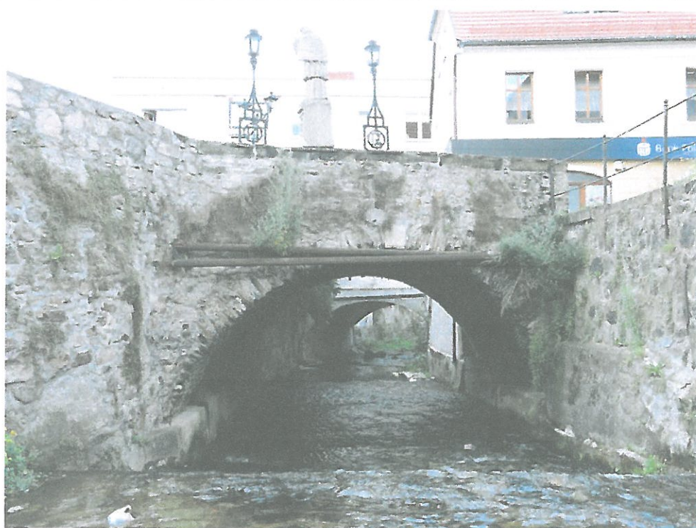
Fot. 4. Widok elewacji obiektu od strony górnej wody
