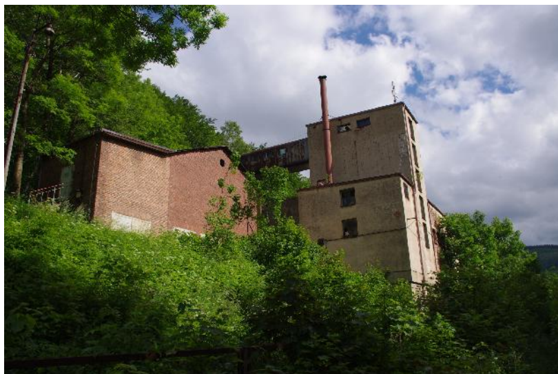
Budynki kopalni „Wolność” dziś. Po prawej stronie dawny szyb „Wolność”
