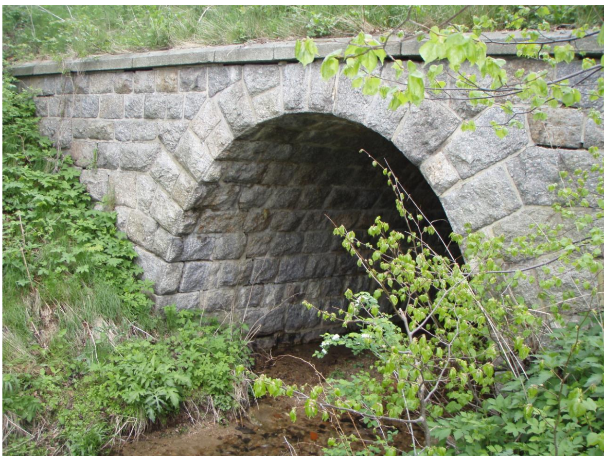
Widok od dolnej wody
