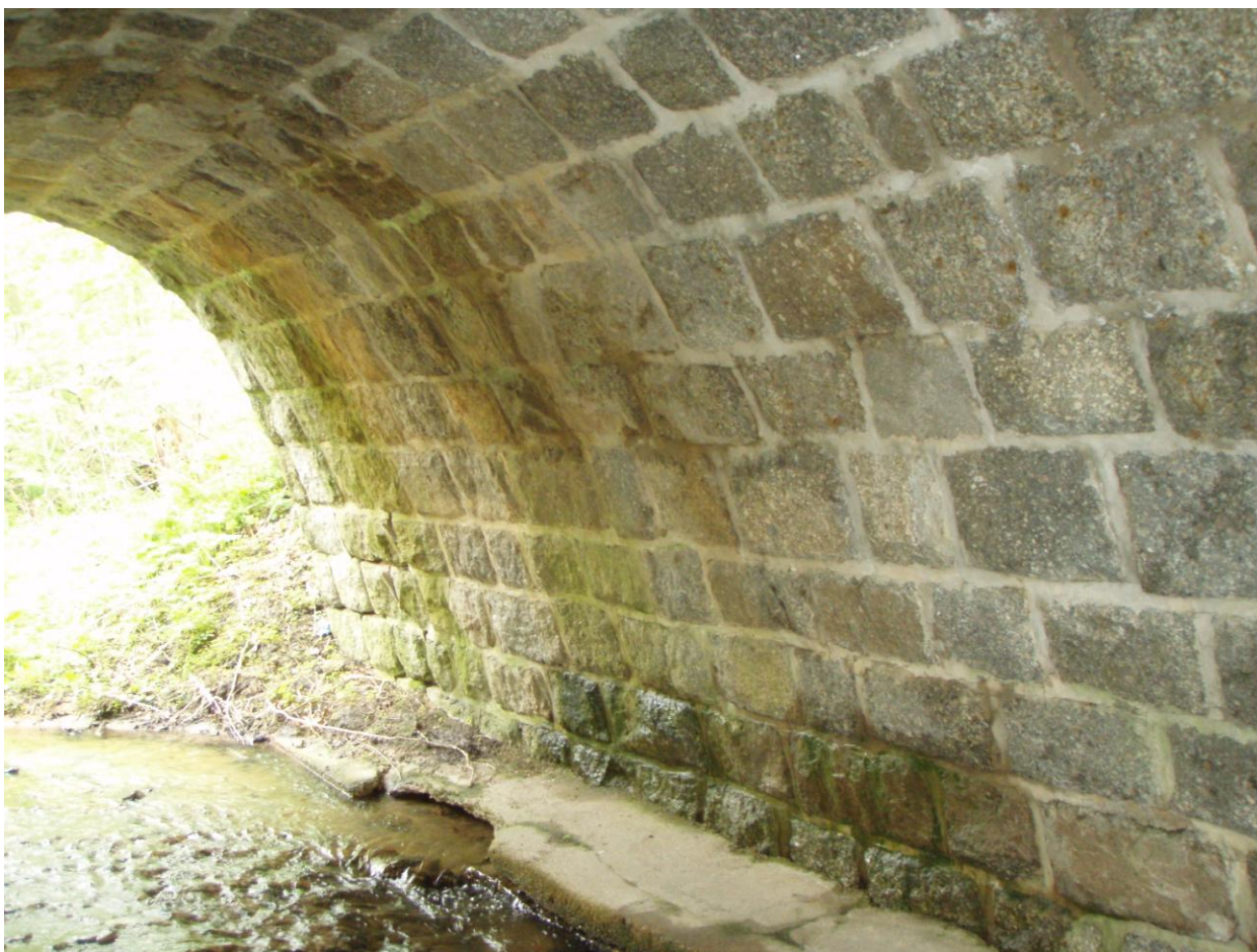
Wysięki na lewobrzeżnym przyczółku
