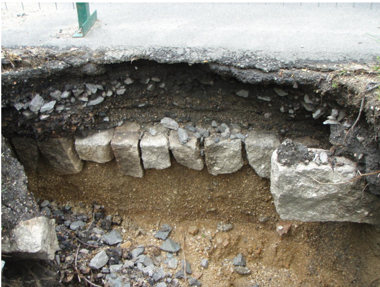
Warstwy konstrukcyjne nawierzchni na moście
