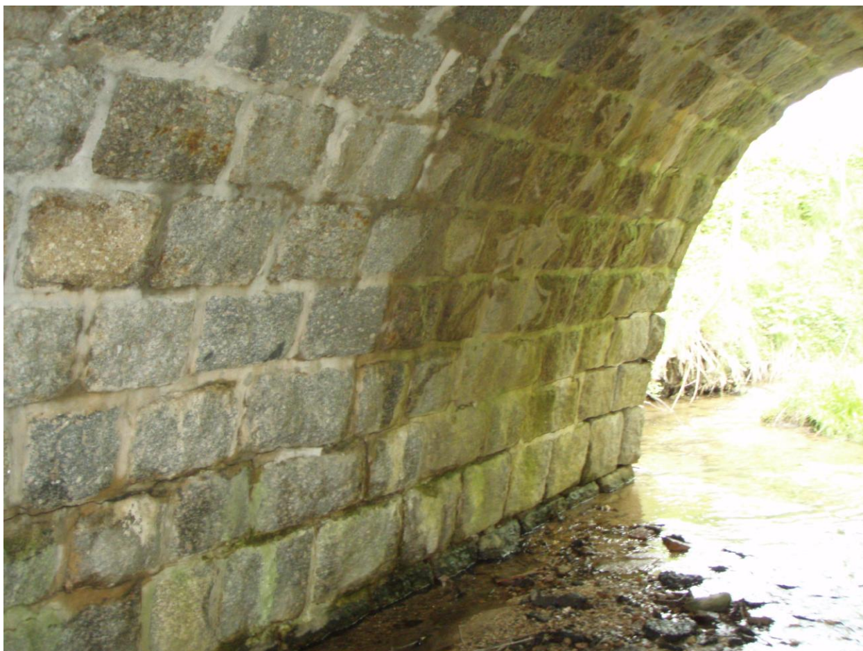
Wysięki na prawobrzeżnym przyczółku
