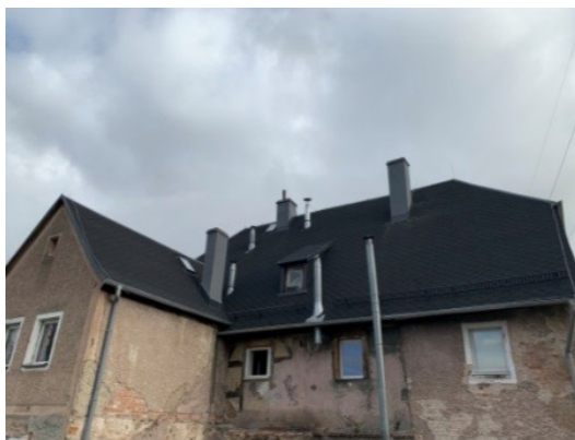
ul. Kowalska 24 – nowe pokrycie dachowe
