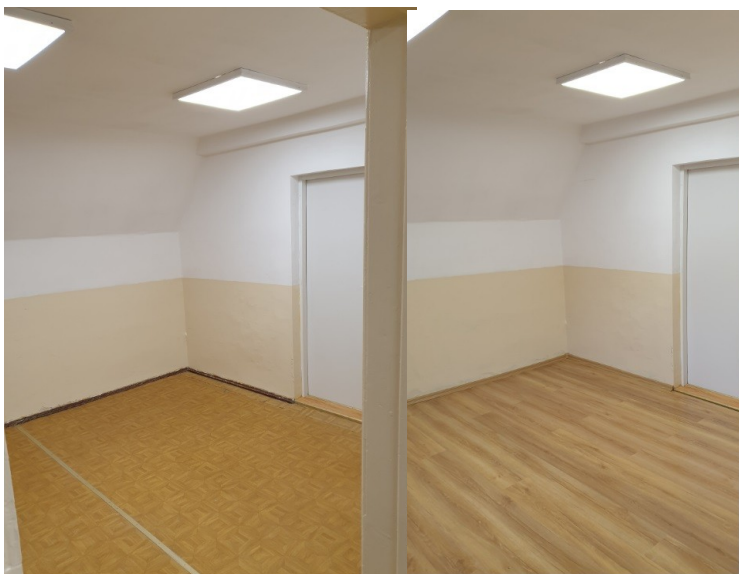
Świetlica nr 1 – przed remontem
