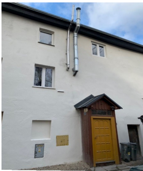
ul. 1-go Maja 43 – modernizacja budynku
