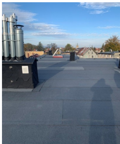
ul. Waryńskiego 13 – termoizolacja dachu
