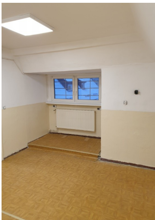
Świetlica nr 2 przed remontem
