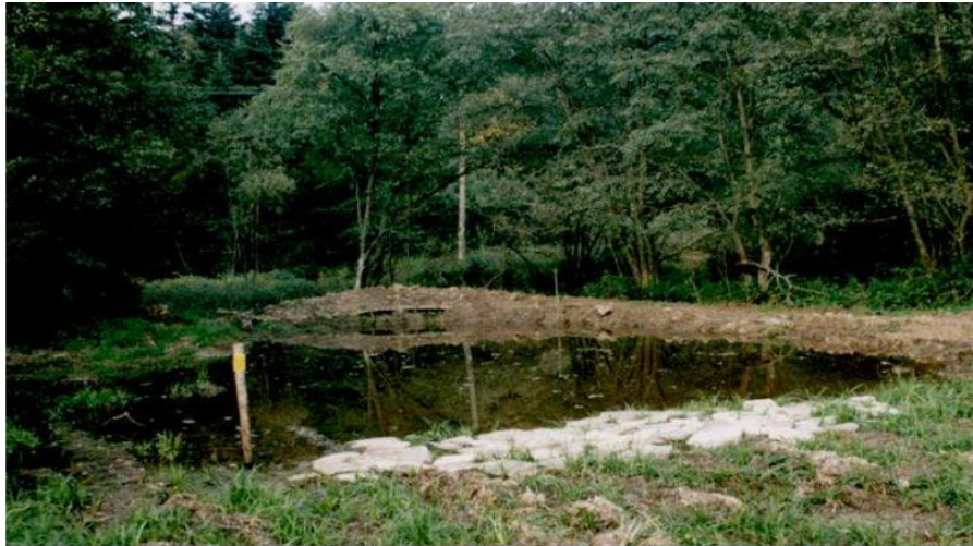
Ryc. 9. Kałuża ekologiczna (wg. Dobre praktyki w realizacji obiektów małej retencji w górach. Przeciwdziałanie skutkom odpływu wód opadowych na terenach górskich. Zwiększenie retencji i utrzymanie potoków oraz związanej z nimi infrastruktury w dobrym stanie, 2010.)
