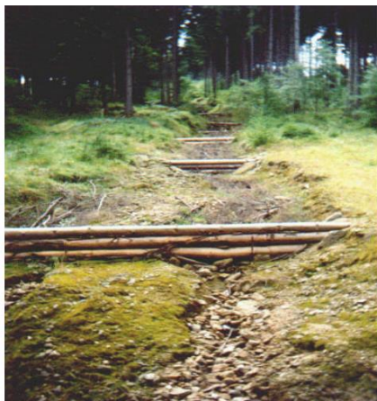
Typowa zabudowa szlaków zrywkowych z wykorzystaniem belek drewnianych
