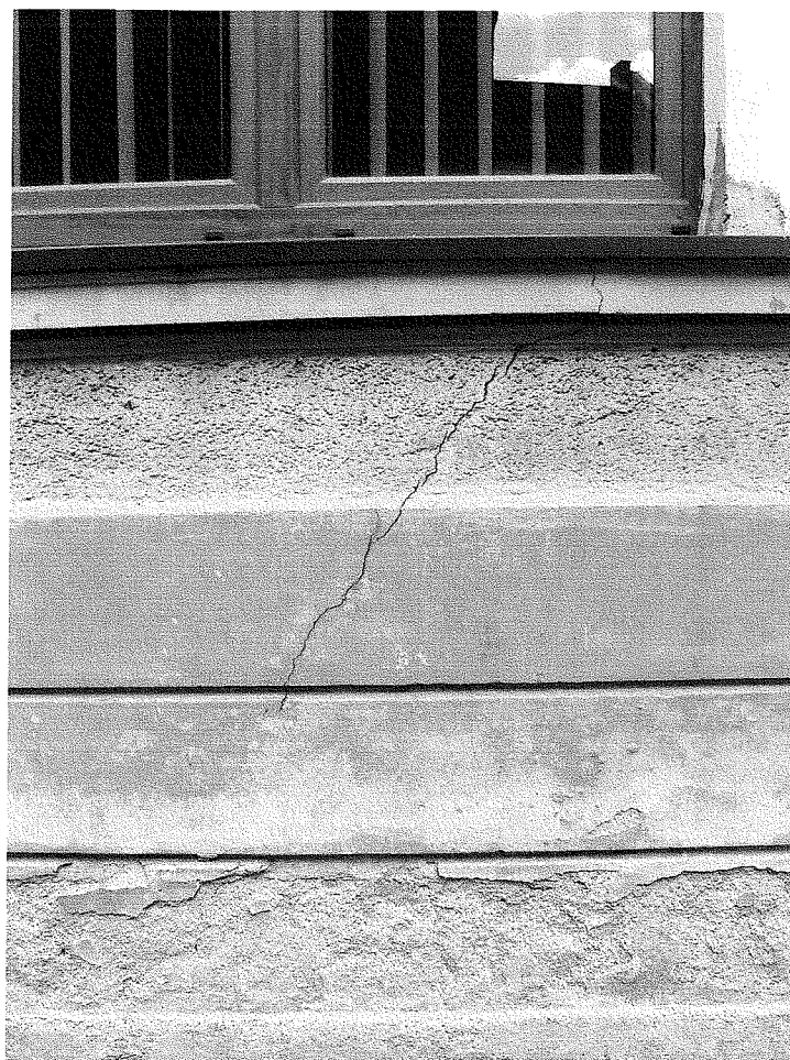
3 Pęknięcie na elewacji frontowej
