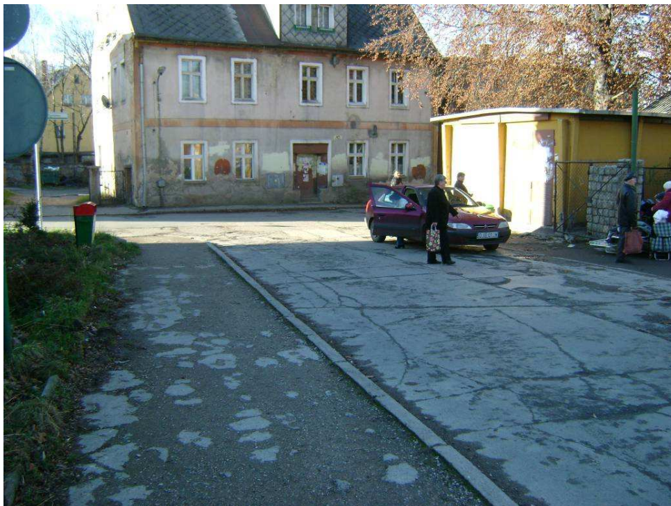
Fot.7 Skrzyżowanie ulicy Klonowej z ulicą Ogrodową. Widoczna nawierzchnia jezdni i chodnika.
