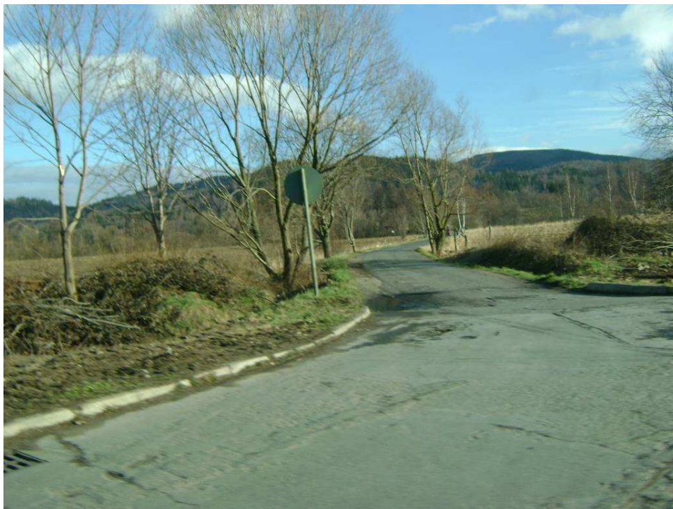
Fot.3 Skrzyżowanie ulicy Lipowej i łącznika asfaltowego.
