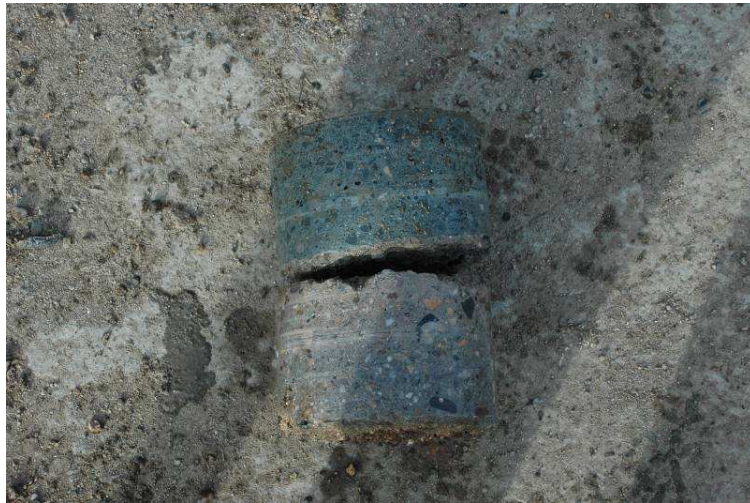
Fot.1 Widoczny odwiert w nawierzchni betonowej
