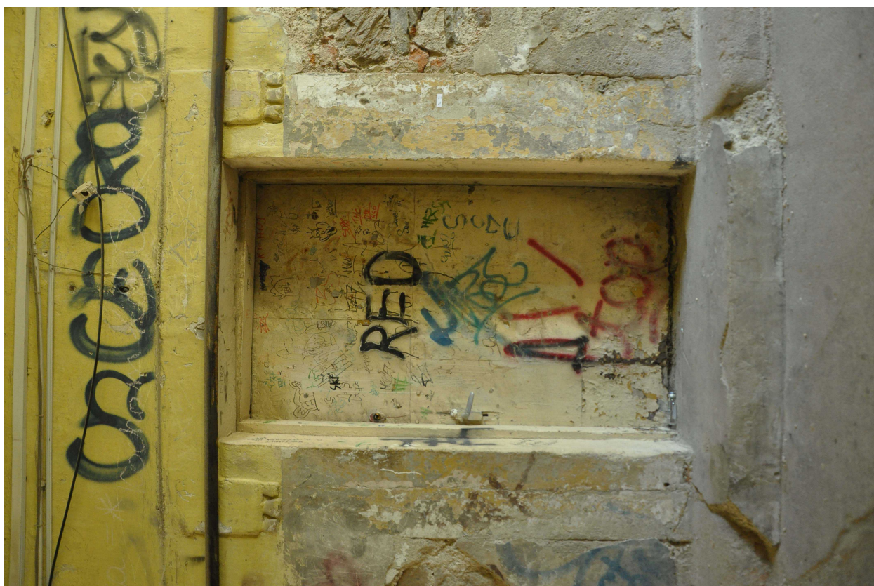
fot. 12. Ściana lewa: zamknięcie zejścia do piwnicy
