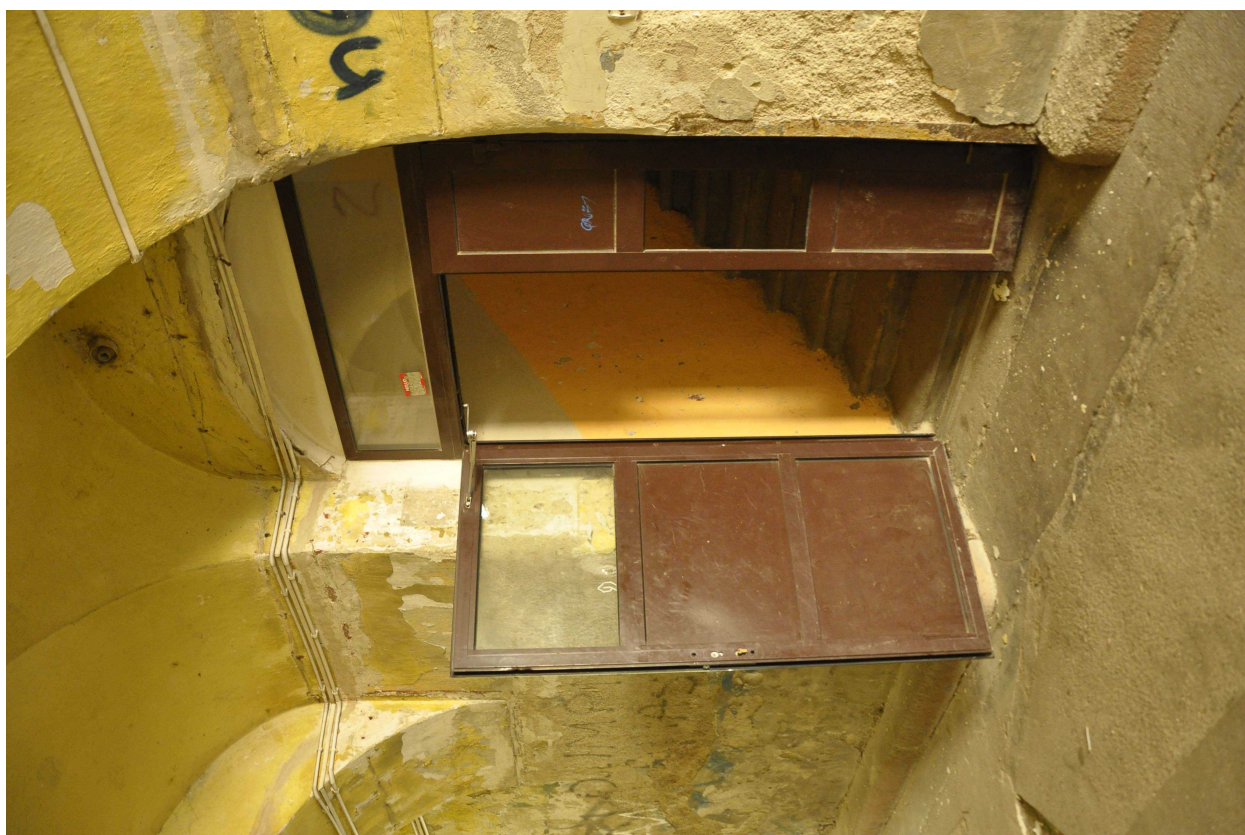
fot. 10. Ściana prawa: stolarka wejścia do klatki schodowej
