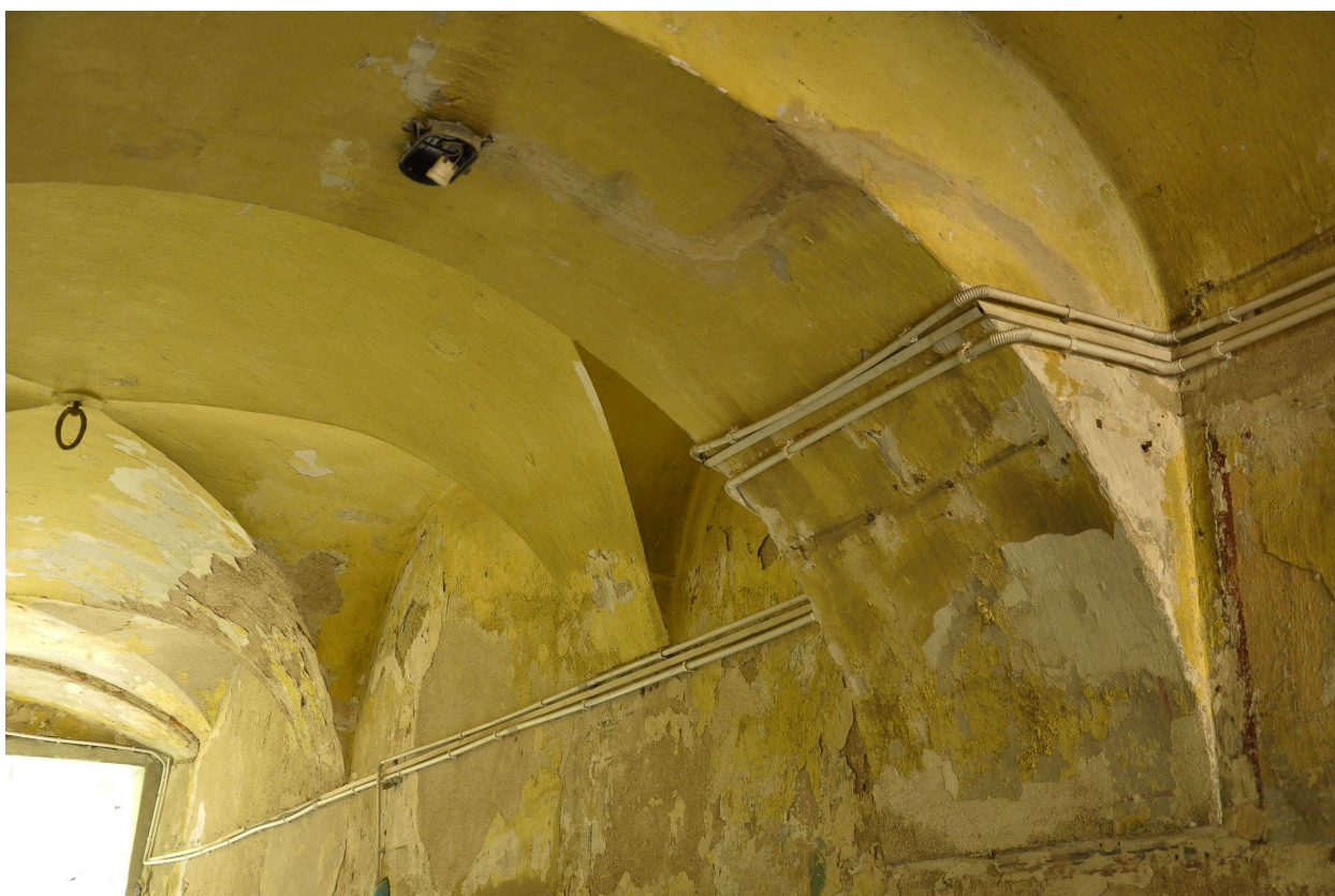
fot. 16. Zejście sklepień na prawą ścianę
