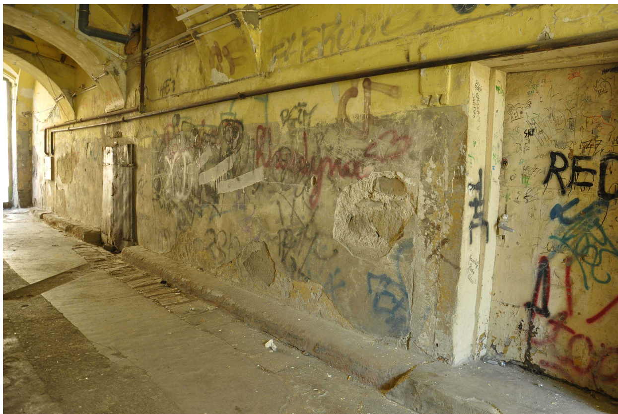
fot. 7. Ściana lewa - widok ogólny
