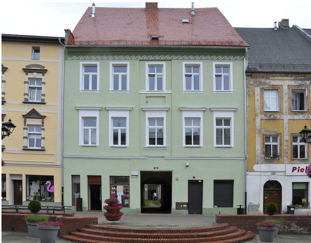
fot. 1. Elewacja frontowa - widok ogólny
