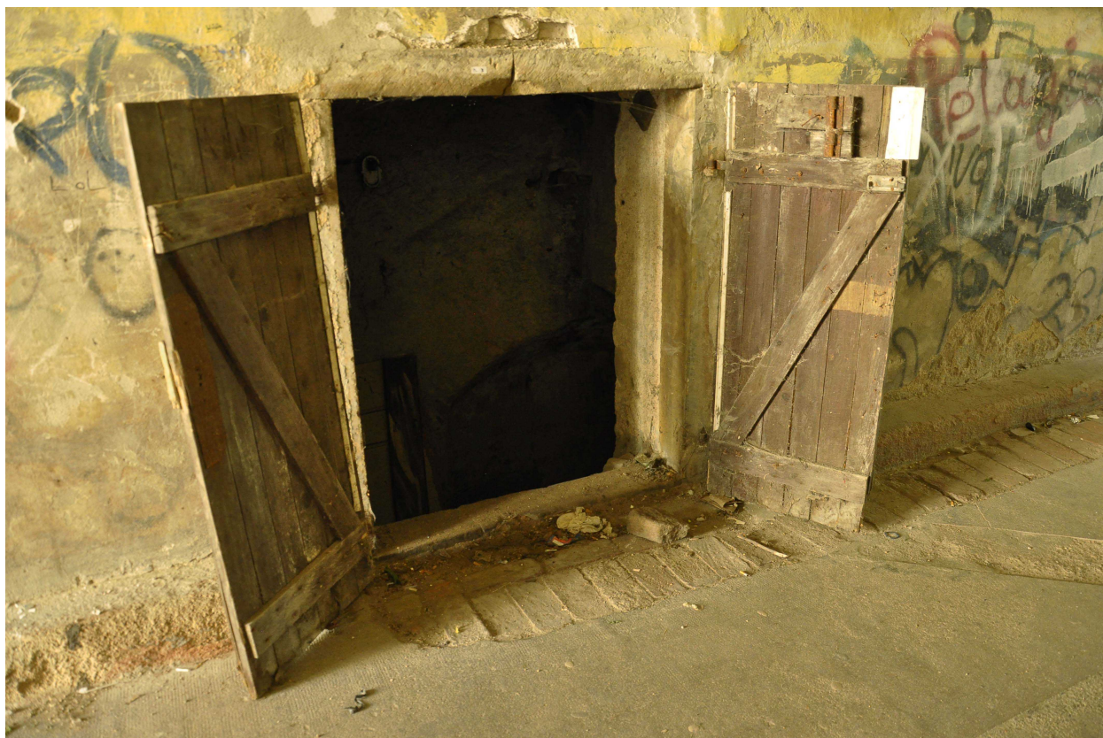
fot. 13. Ściana lewa: zamknięcie zejścia do piwnicy
