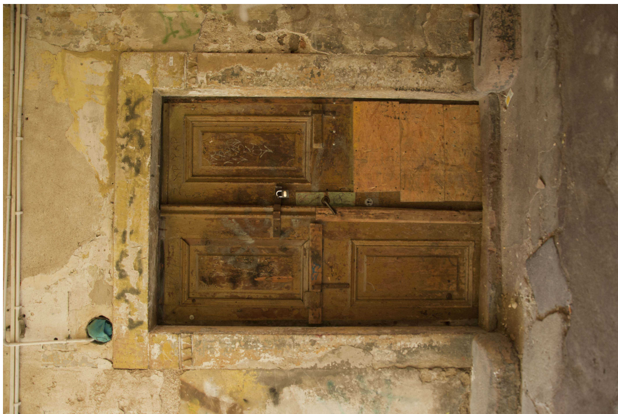
fot. 11. Ściana prawa: stolarka zejścia do piwnicy
