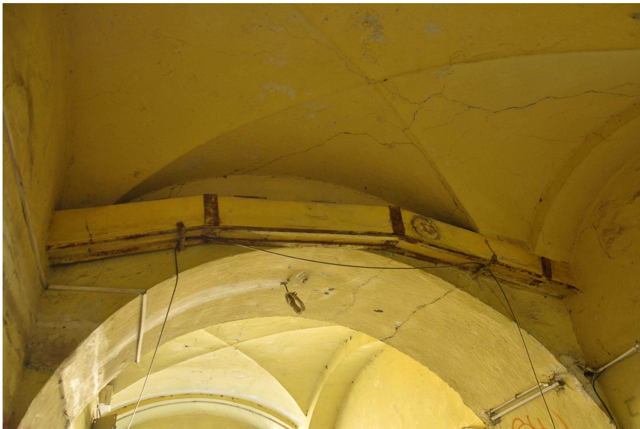
fot. 17. Widok na sklepienie i niezidentyfikowana konstrukcję
