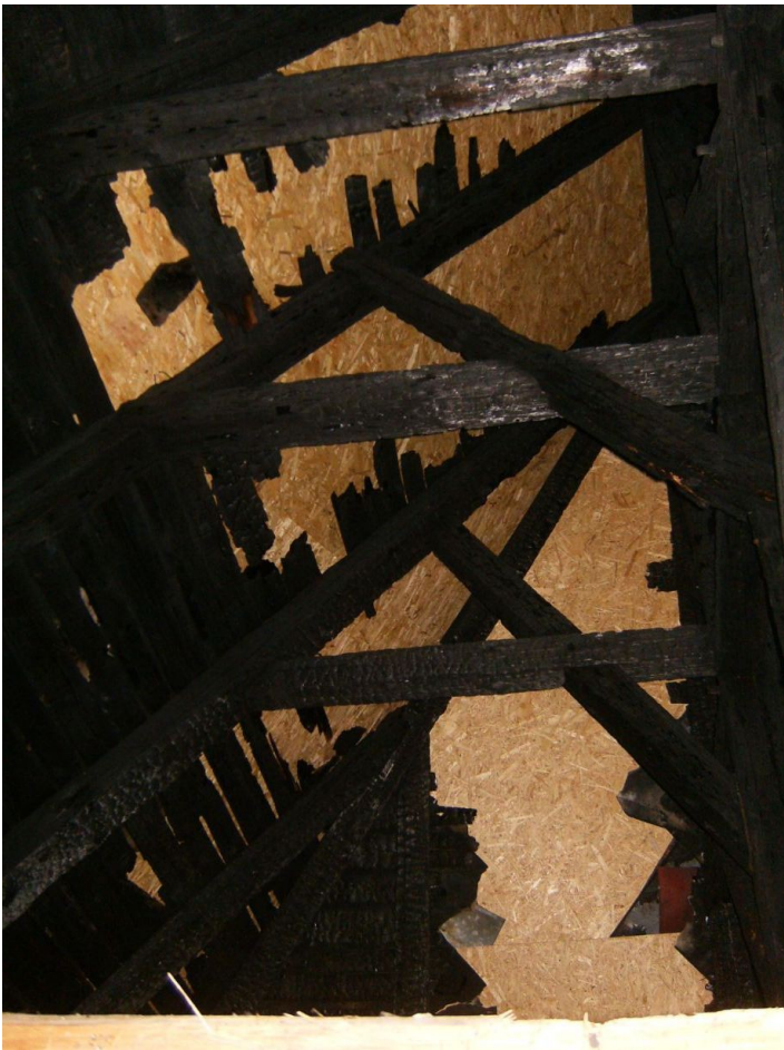
Widok więźby dachowej i dachu od strony strychu – widoczne zniszczone deskowanie doraźnie zastąpione płytami osb
