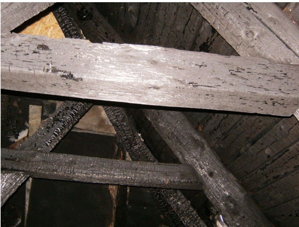
Widok więźby dachowej i dachu od strony strychu – widoczne zniszczone deskowanie doraźnie zastąpione płytami osb
