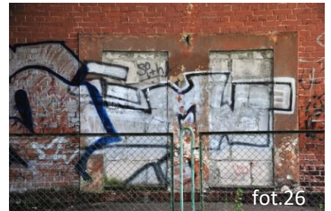
widoczny fragment zamurowanego otworu okiennego (25) oraz drzwiowego (26).
