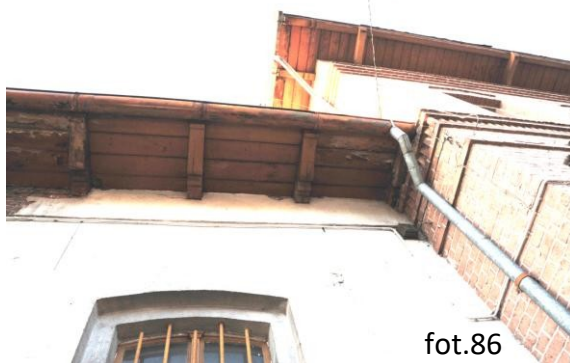
Kroksztyny plombowane (fot.82,83,84) i zachowane w stanie nienaruszonym (fot.85, 86)
