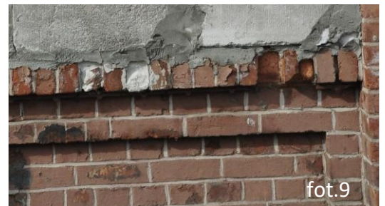
Parapety ceramiczne: miejscowe, mechaniczne uszkodzenia płytek parapetu okna 1 p. oraz uszkodzone cegły parapetu na parterze.
