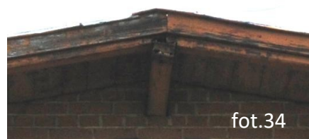
Uszkodzone obróbki dachowe szczytu oraz rynna.
