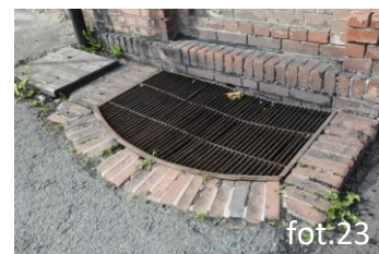
miejscowe uszkodzenia cegieł: wymyta zaprawa, przebarwienia, uszkodzenia lica. Uszkodzenia i ubytki cegły obudowy studni piwnicznej (20). Widoczne zniszczenia skrzydeł drzwiowych i rury spustowej (21).
