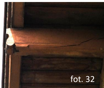
Pęknięta krokszyna belki konstrukcji dachu (32), krokszyny i deski dachowe w dobrym stanie technicznym (33).
