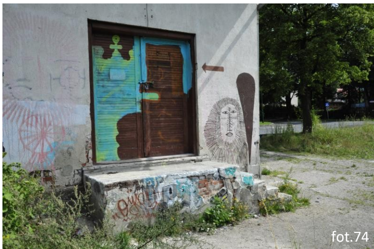
Schody zewnętrzne, widoczne liczne pęknięcia i ubytki w konstrukcji schodów
