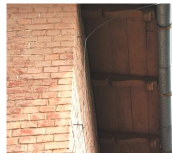
Pęknięta krokszyna belki konstrukcji dachu (32), krokszyny i deski dachowe w dobrym stanie technicznym (33).
