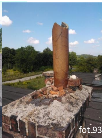
Kominy na dachu (C). Widoczne pęknięcia, ubytki, zagruzowania.
