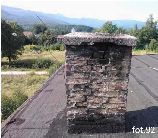
Kominy na dachu (C). Widoczne pęknięcia, ubytki, zagruzowania.
