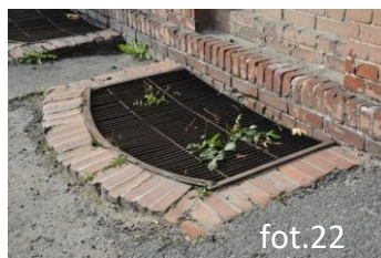
miejscowe uszkodzenia cegieł: wymyta zaprawa, przebarwienia, uszkodzenia lica. Uszkodzenia i ubytki cegły obudowy studni piwnicznej (20). Widoczne zniszczenia skrzydeł drzwiowych i rury spustowej (21).
