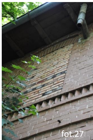
Zamurowane okno (25 i 27) oraz widoczne miejscowe uszkodzenia cegieł (28): wymyta zaprawa, przebarwienia, uszkodzenia lica. Na fot. 27 widoczny fragment instalacji wentylacyjnej łazienki lokalu mieszkalnego.
