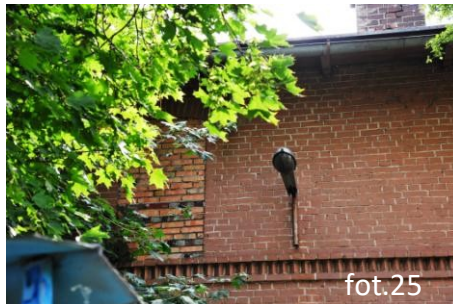
widoczny fragment zamurowanego otworu okiennego (25) oraz drzwiowego (26).
