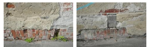
Widoczne odstąpięte nadproża ceramiczne okien piwnicznych oraz odkryte czoła drewnianych belek stropowych.
