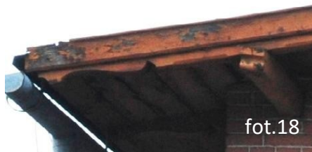
widoczne uszkodzenia obróbek dachowych szczytu budynku, złuszczone farba, zdeformowane zewnętrzne fragmenty belek konstrukcji dachu.
