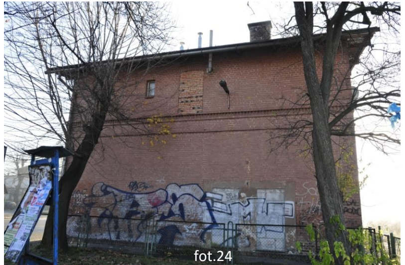
Dworzec PKP: elewacja północno-zachodnia.
