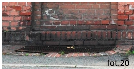
miejscowe uszkodzenia cegieł: wymyta zaprawa, przebarwienia, uszkodzenia lica. Uszkodzenia i ubytki cegły obudowy studni piwnicznej (20). Widoczne zniszczenia skrzydeł drzwiowych i rury spustowej (21).
