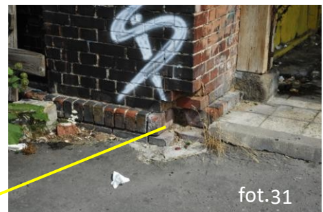
Segment z poddaszem nieużytkowym, Widoczne uszkodzenia cokołu.
