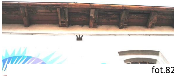
Elewacja pld.wsch. część parterowa. Widoczne plomby kroksztyny i złamana krokwia na murłacie.
