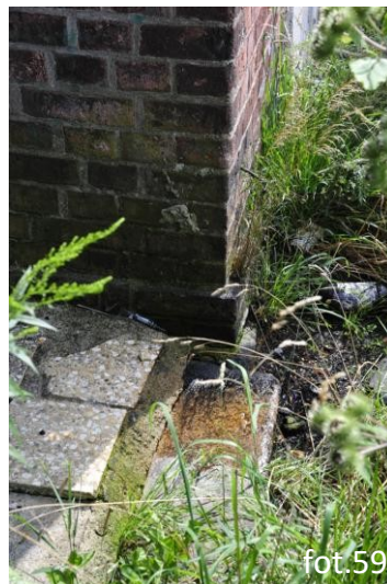
Widoczny zniszczony narożnik i posadzka segmentu C (przy wiacie) fot. 59 oraz zamurowane otwory drzwiowy i okienny.
