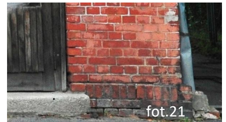
miejscowe uszkodzenia cegieł: wymyta zaprawa, przebarwienia, uszkodzenia lica. Uszkodzenia i ubytki cegły obudowy studni piwnicznej (20). Widoczne zniszczenia skrzydeł drzwiowych i rury spustowej (21).
