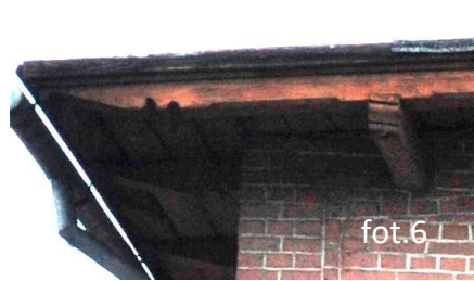
widoczne uszkodzenia obróbek dachowych szczytu budynku oraz poziome rozwarstwienia krokwi.
