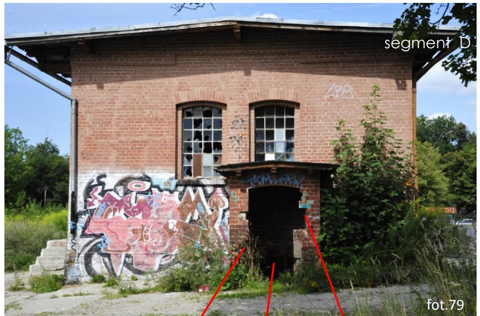
Elewacja pld.wsch. część parterowa. Widoczne wejście do piwnicy,
