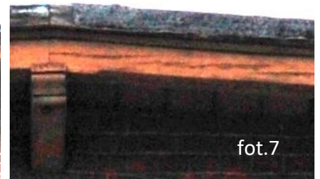
widoczne uszkodzenia obróbek dachowych szczytu budynku oraz poziome rozwarstwienia krokwi.
