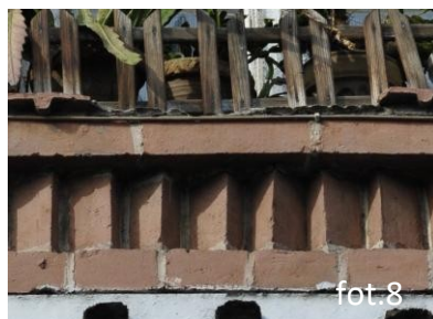
Parapety ceramiczne: miejscowe, mechaniczne uszkodzenia płytek parapetu okna 1 p. oraz uszkodzone cegły parapetu na parterze.
