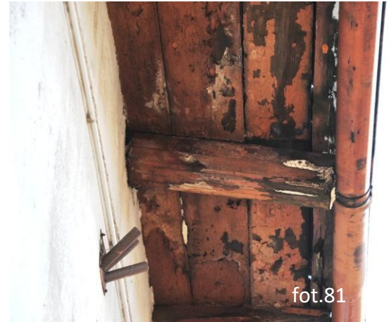
Elewacja pld.wsch. część parterowa. Widoczne plomby kroksztyny i złamana krokwia na murłacie.
