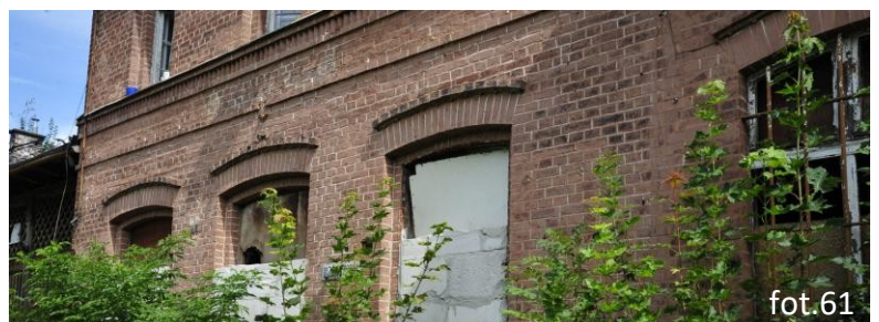
Nadproża ceglane i fragment gzymsu międzykondygnacyjnego.
