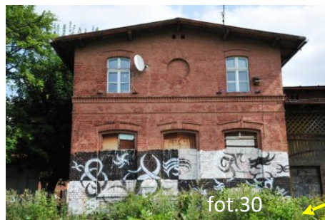
Segment z poddaszem nieużytkowym, Widoczne uszkodzenia cokołu.
