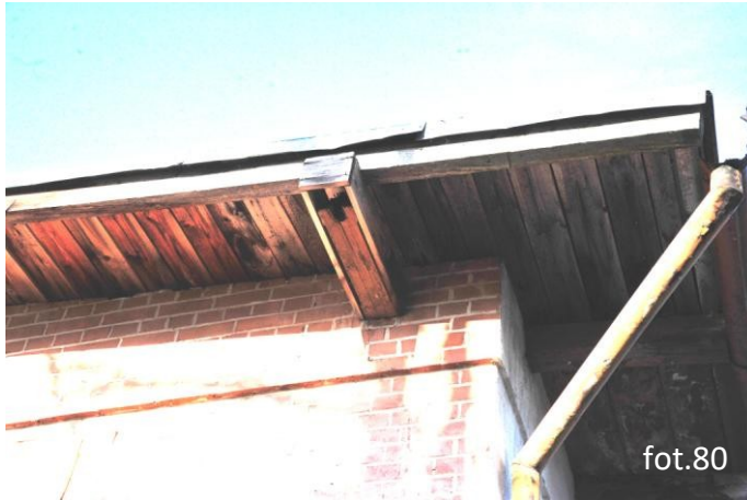
Elewacja pld.wsch. część parterowa. Widoczne plomby kroksztyny i złamana krokwia na murłacie.
