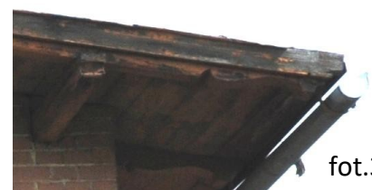
Uszkodzone obróbki dachowe szczytu oraz rynna.
