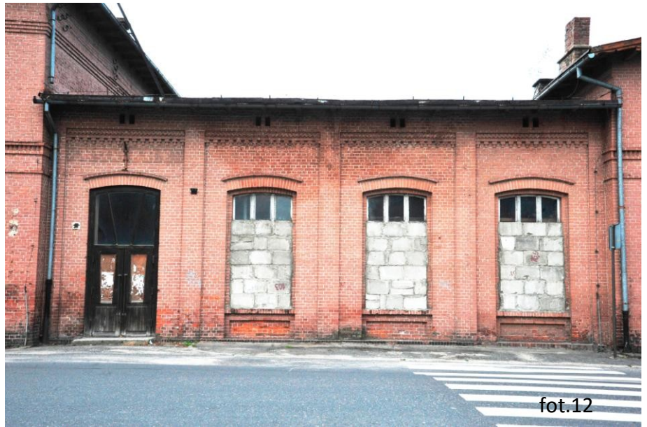
Dworzec PKP: Segment B Elewacja północno-wschodnia, poczekalnia.
