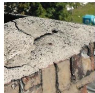
Kominy na dachu (C). Widoczne pęknięcia, ubytki, zagruzowania.
