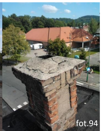
Kominy na dachu (C). Widoczne pęknięcia, ubytki, zagruzowania.
