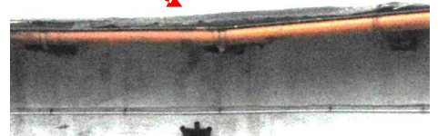
Widoczne zniszczenia pokrycia dachu, pasa rynnowego i rynny.
