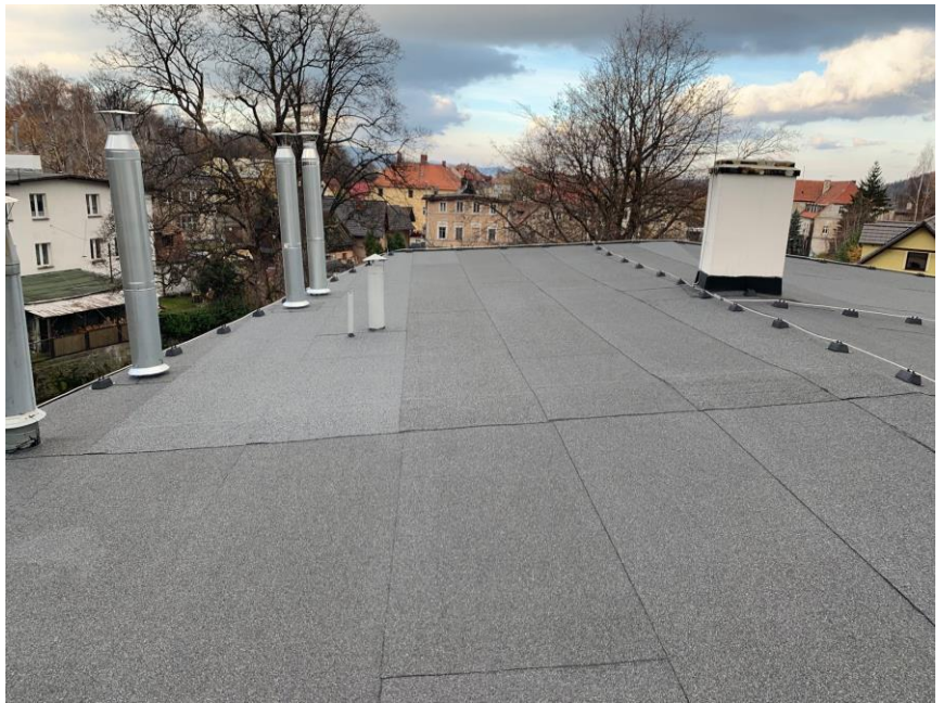
Remont pokrycia dachu budynku przy ul. Waryńskiego 20 w Kowarach
