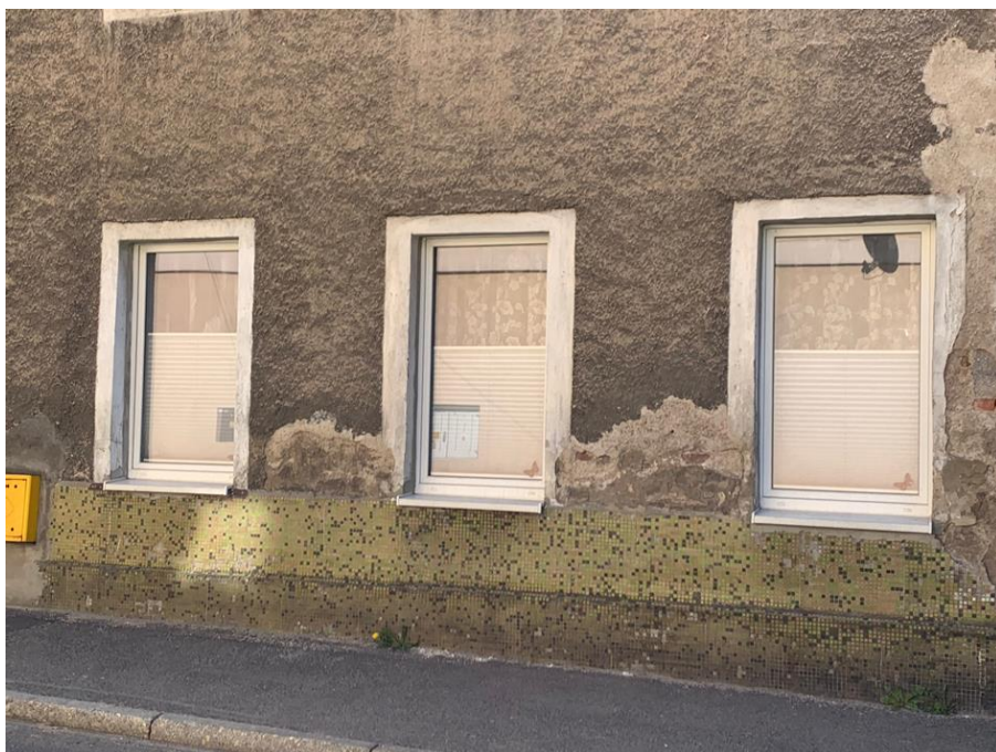
Montaż stolarki okiennej w lokalu mieszkalnym nr 1 przy ul. Ogrodowej 48 w Kowarach.
