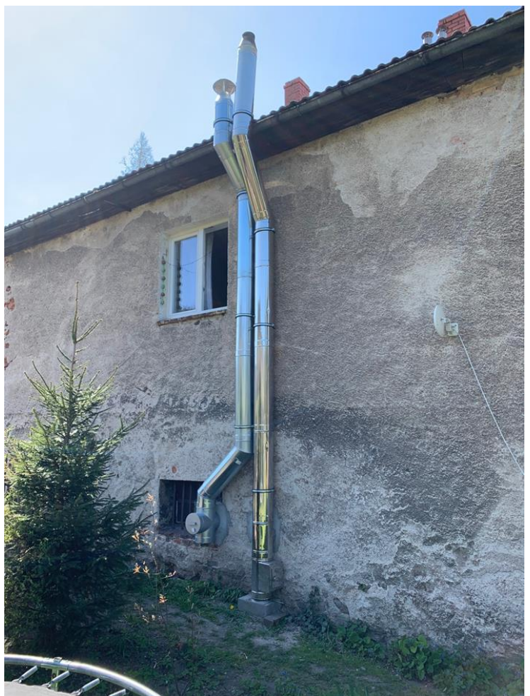
Montaż komina dwupłaszczowego oraz komina wentylacyjnego w lokalu nr 2 w budynku przy ul. Wiejskiej 43 w Kowarach
