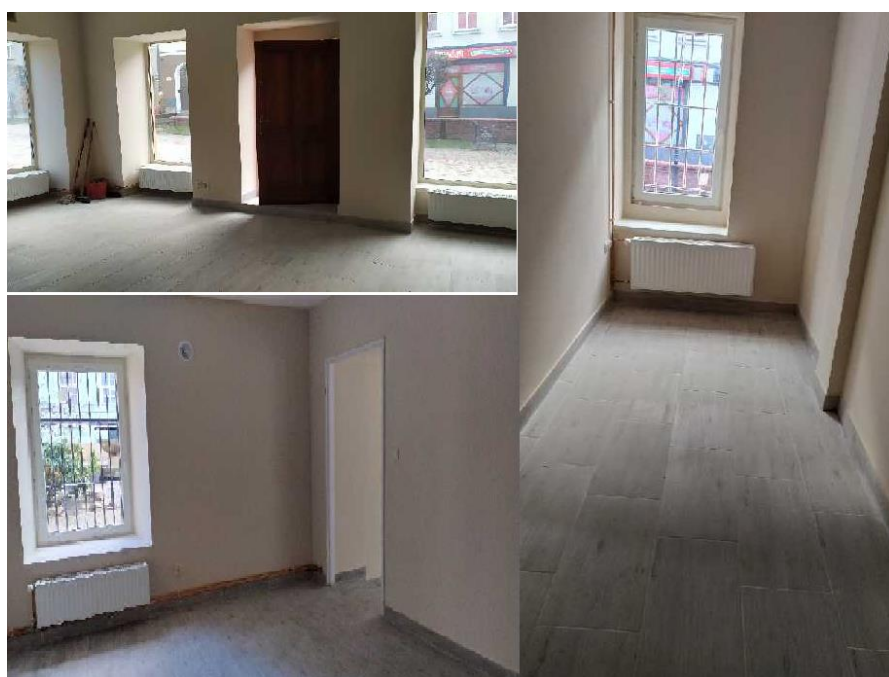
Remont lokalu użytkowego z zaprojektowaniem i wykonaniem instalacji c.o. zasilanej kotłem gazowym w budynku przy ul. 1 Maja 9 w Kowarach
